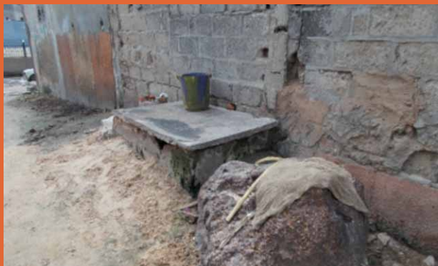
Fosse septique dans une maison à Dakar (Sénégal)
