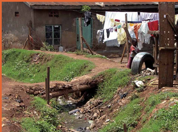
Canal d'évacuation mal entretenu à Kampala en Ouganda
